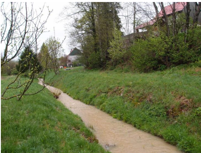
Fotografija 3: Pogled s sjeveroistočne strane na k-č- 725/4 i 725/5 (desno od vodotoka)
